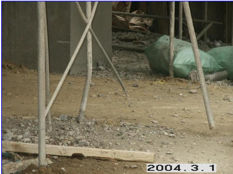
照片 7：施工架之立架腳柱變形，影響施工架之強度。
