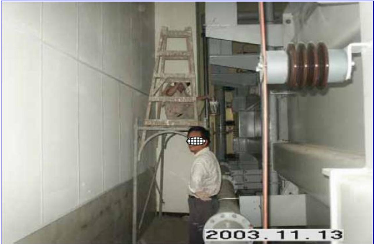
照片 12：施工架上違規設置合梯從事油漆作業。
