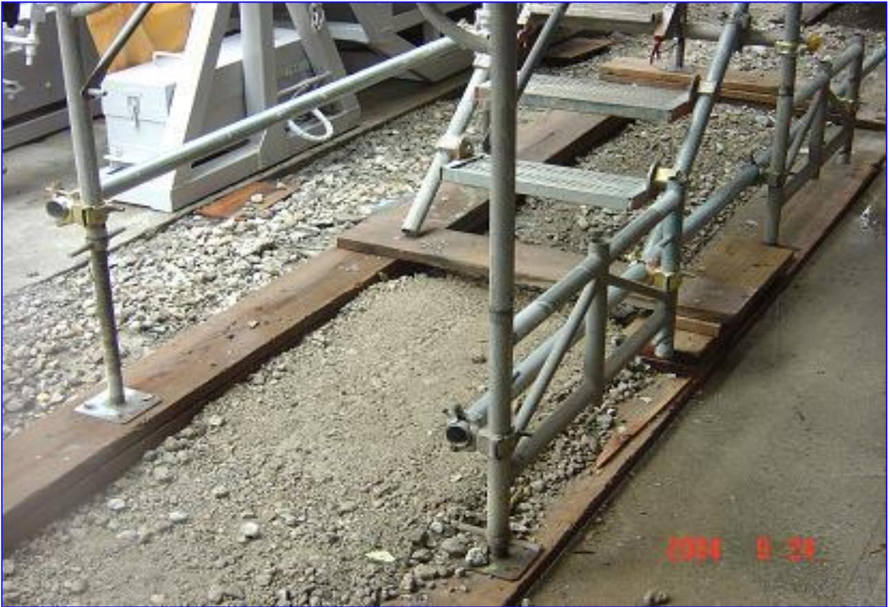
照片 10：施工架底部之立架應設可調型基腳座板，基礎地面應平整、夯實緊密、襯以適當材質之墊材，以避免產生不均勻沉陷。
