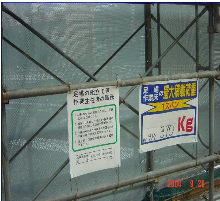
照片 9：施工架上之載重限制，應於明顯易見之處明確標示（以標示單一踏板載重限制為原則；另如經設計須標示整組施工架載重限制，則依須求增加標示該內容）。
