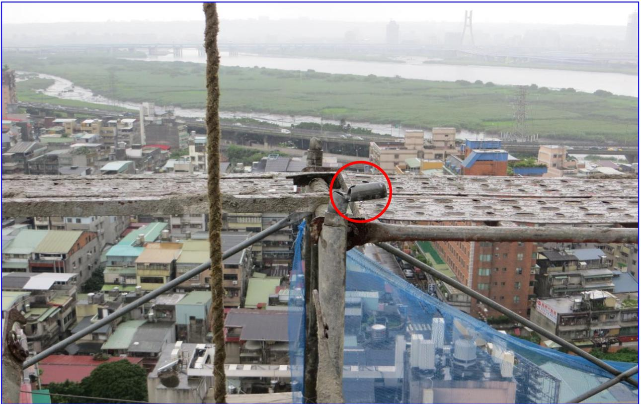
照片 14：未以機械吊運，使用繩索並以立架為支點，以人力吊運整捆交叉拉桿及下拉桿，人員隨倒塌之立架墜落（腳柱接頭斷裂）。
