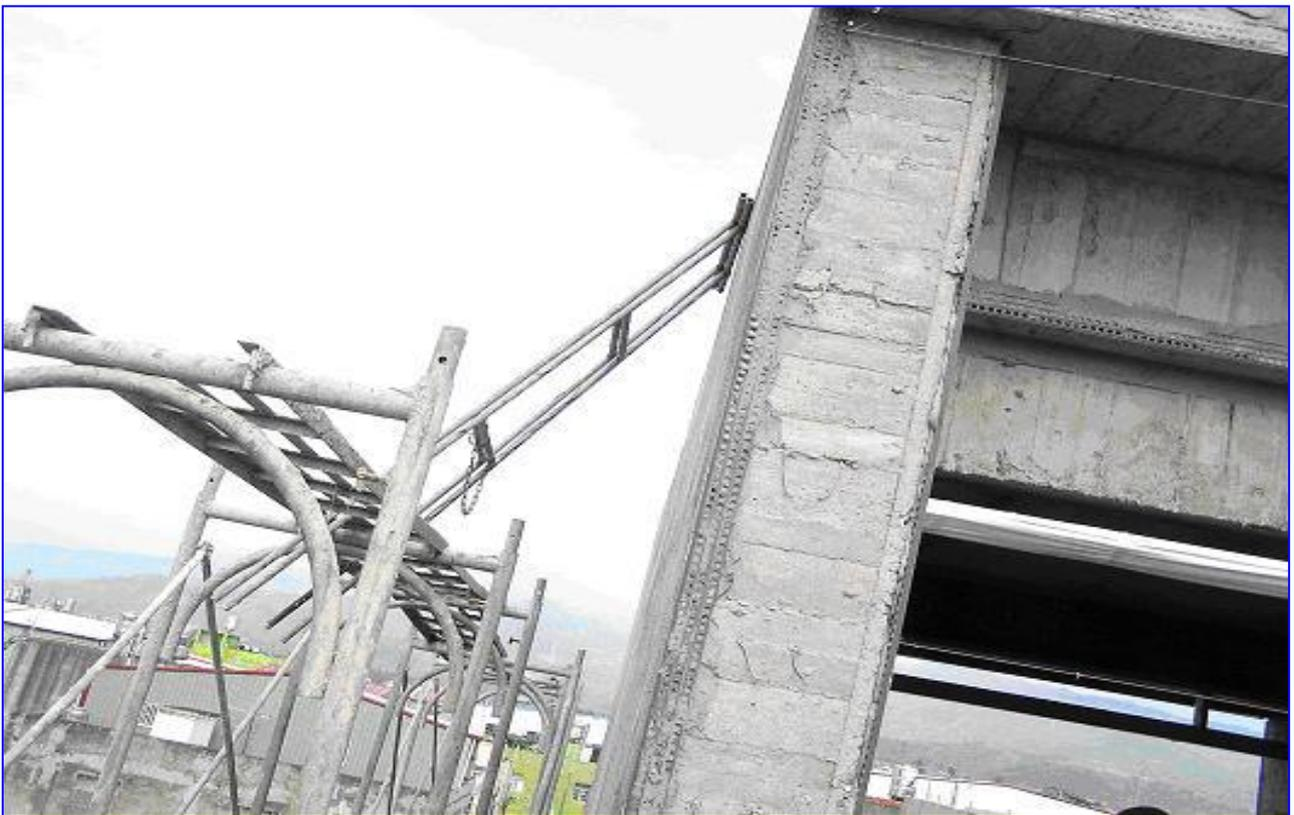
照片 11：施工架上違規設置梯子當上下設備。
